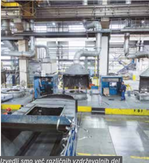
Izvedli smo več različnih vzdrževalnih del
