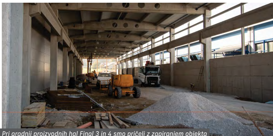
Pri gradnji proizvodnih hal Final 3 in 4 smo pričeli z zapiranjem objekta
