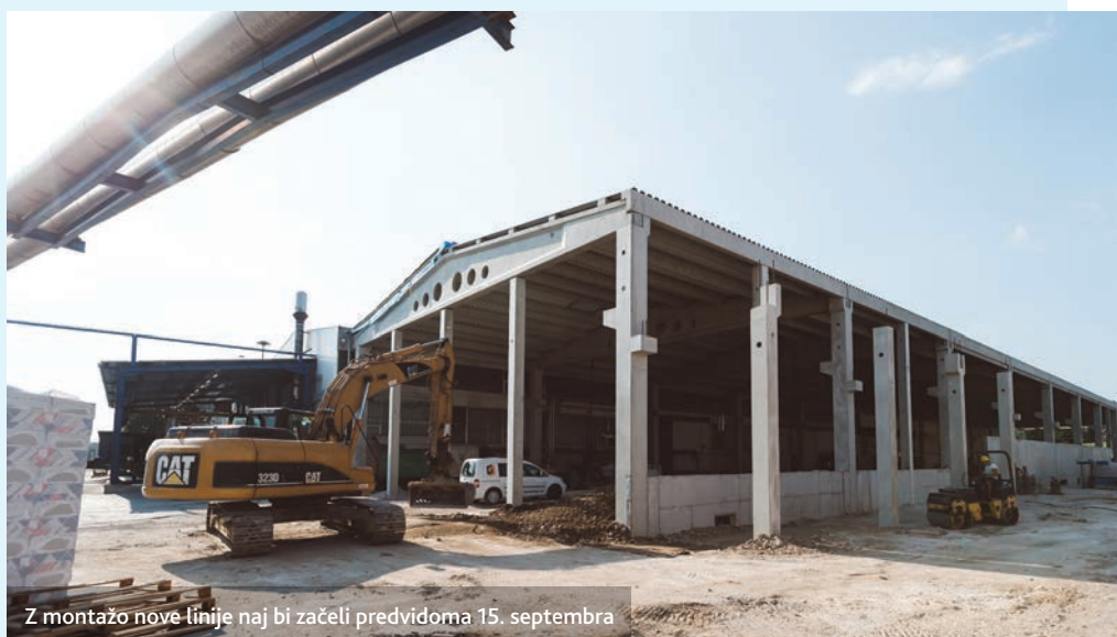
Končana je prva faza postavitve avtomatskega regalnega skladišča drogov
